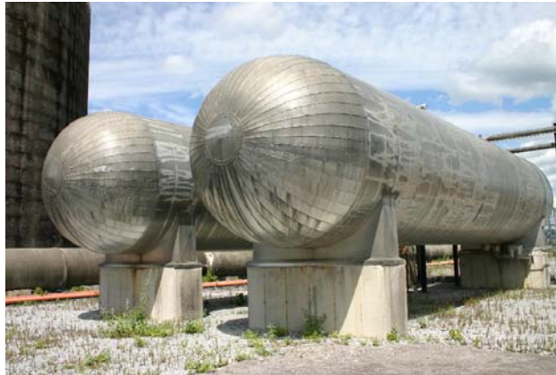
شکل ۵-۱ مخزن تحت فشار افقی
